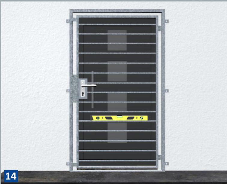
**14** Danach stecken Sie umlaufend jede Schraube durch die Bohrlöcher der Befestigungslaschen der Gittertür in die Dübel und drehen diese kurz mit der Hand im Uhrzeigersinn in den Dübel ein. Wenn alle Schrauben des Gitters vorbereitet sind, wird die Wasserwaage zum Ausrichten des Gitters angelegt und nach kontrolliert.
