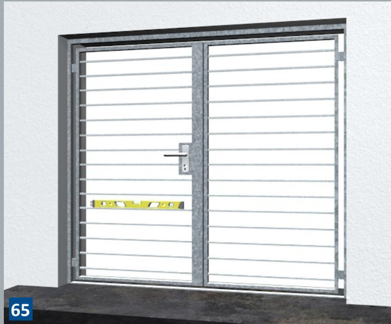
**65** Kontrollieren Sie nun erneut mithilfe einer Wasserwaage die Ausrichtung der Gittertür.
